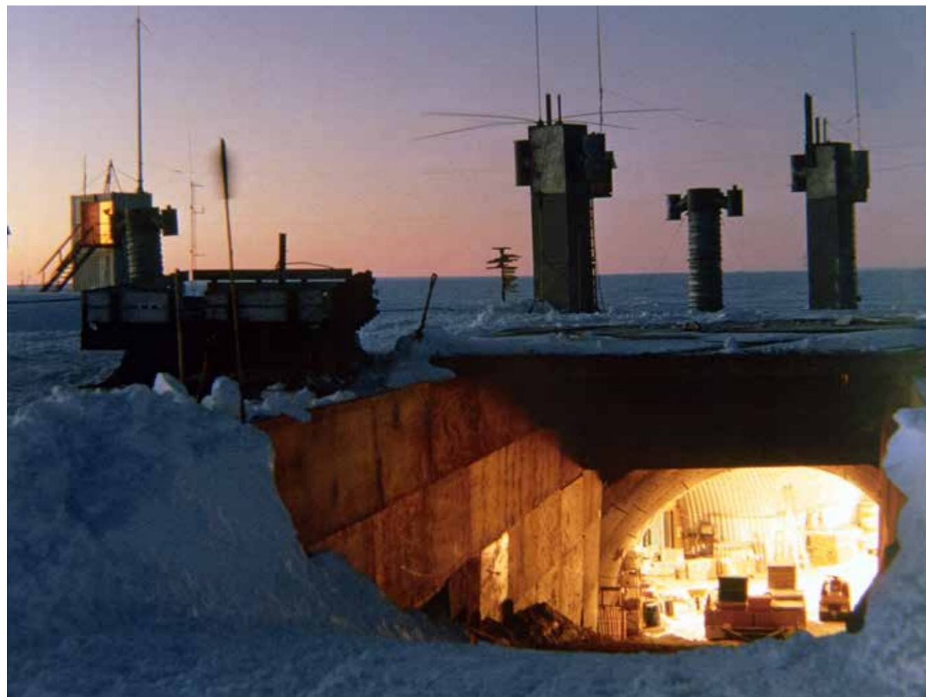
Eine Rampe führt in die Georg-von-Neumayer-Station neun Meter unter dem Eis.
